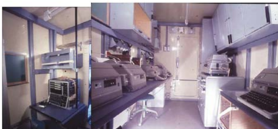
Bilderna visar telefonväxeln och fjärrskriftsapparater samt mottagare för väderkartor
