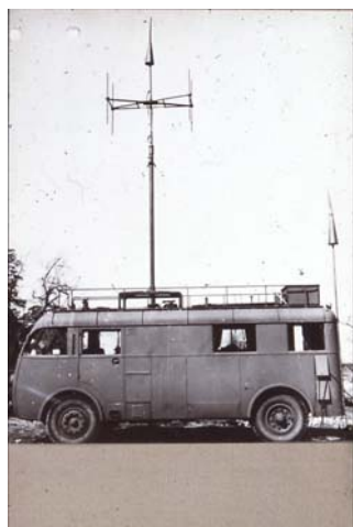
Kommandoplatsbuss (Kpl-buss) som användes på krigsflygbas fram till slutet av 1950-talet. Ersattes av Tlf-kärran. På taket en pejlantenn (Fmp 5) och konantenn för flygradio (Fr 5)
