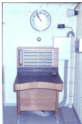
Telefonväxeln i kommandocentralen (KC). Betjänades av värnpliktig telefonist. Plats för 100 abonnenter. Tre televerksanknytningar (ATN) som användes för samtal utanför krigsbasen. Dessutom fanns flera direktkopplade förbindelser till stridsledningscentraler och till krigsbasens andra manuella telefonväxlar.
