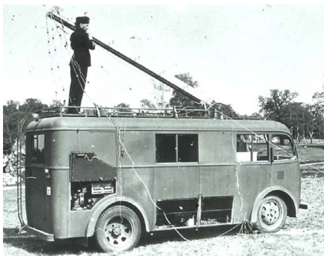
Transportabel markradio (Tmr 9 och Tmr 8) som användes för att via kortvågsförbindelse skicka meddelanden mellan flottiljer och krigsflygbaser. Betjänades av telegrafister.
