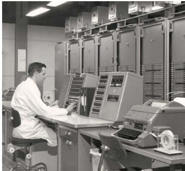
TAC datorn med trådminnesenheter i bakgrunden. Foto Lfc 05
