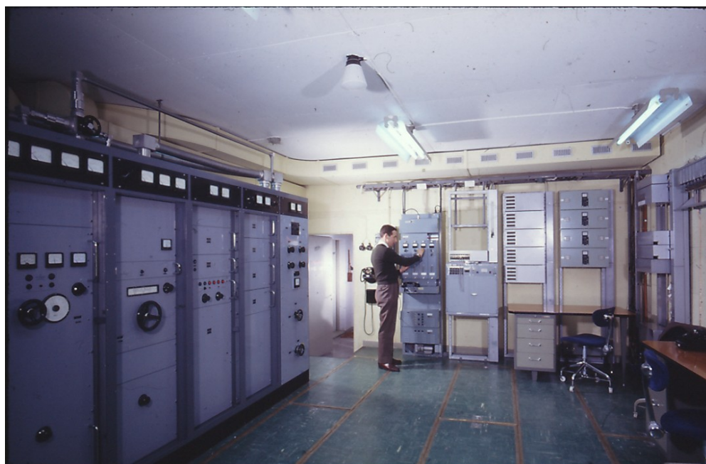
FMR-10 sändare i dess apparatrum
