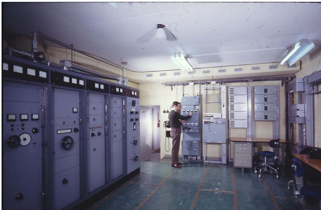
Telerum med FMR-10 och radiolänkutrustning.
