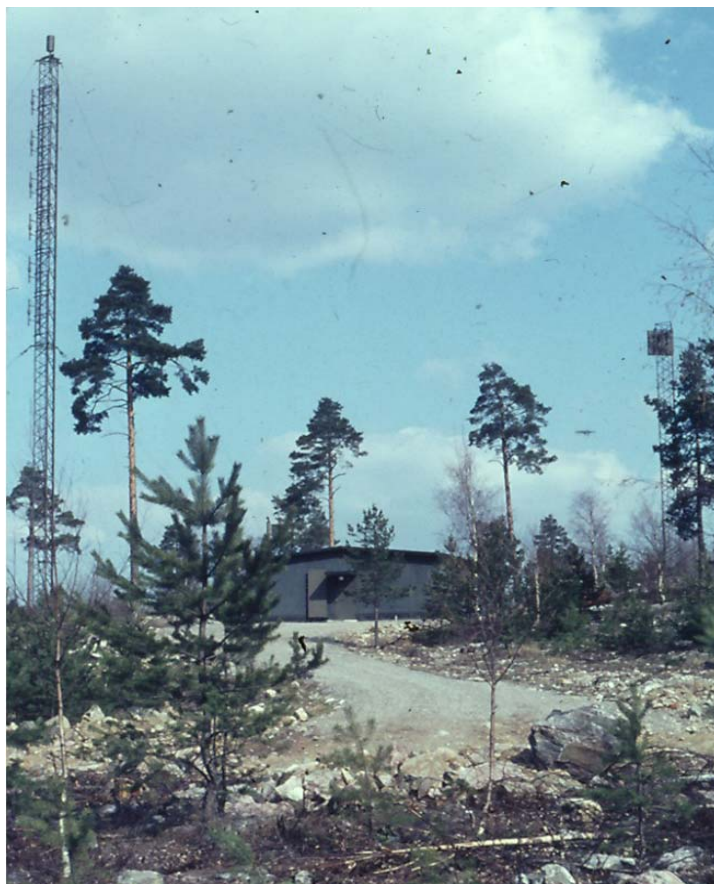
FMR 10 sändaranläggning med radioantenn AU287/051 och med HA74/21 installerad på antennmastens topp.
